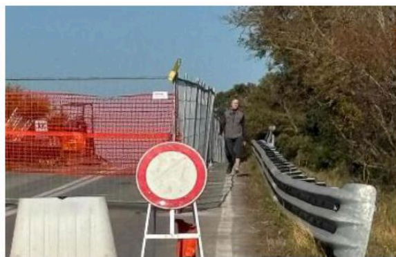
Il ponte sulla provinciale 54 chiuso per lavori, resta solo una passerella
