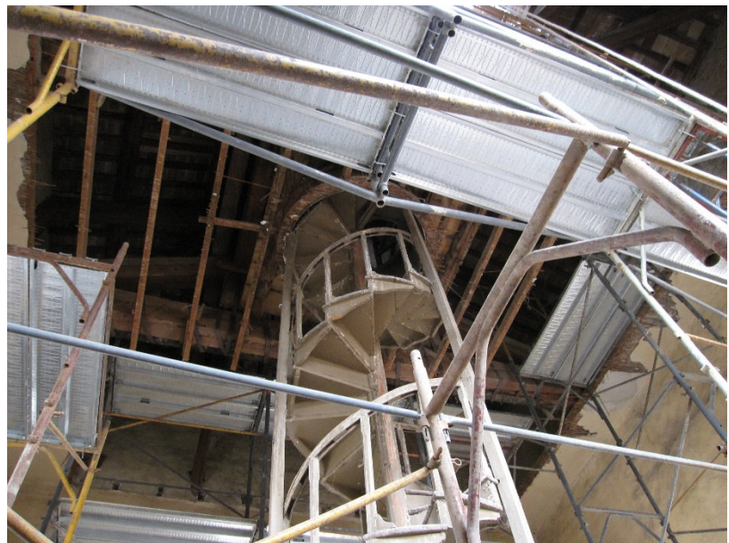
Vista della scala a chiocciola in legno originale di collegamento alla lanterna della Torre Santa Caterina, smontata durante gli interventi di messa in sicurezza strutturale del 2014, di cui oggi resta un campione in situ.
