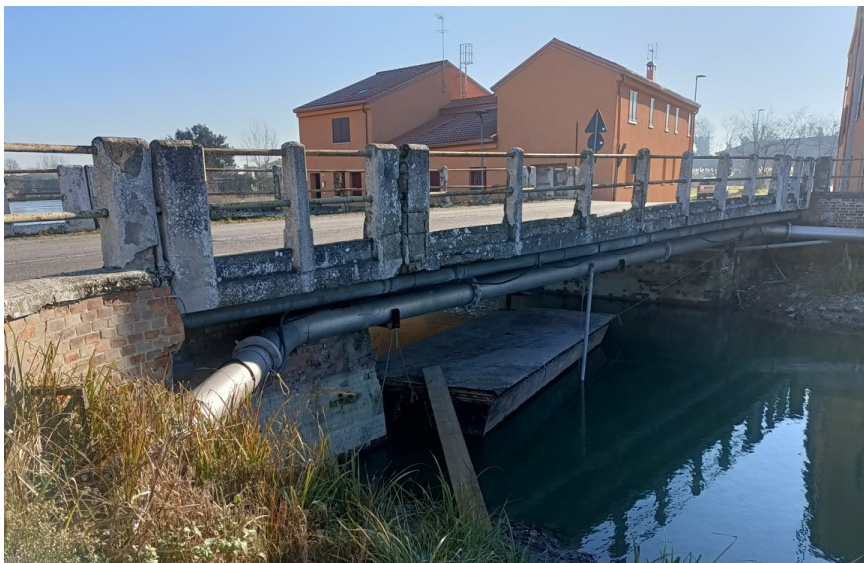
Ponte oggetto di manutenzione straordinaria alle strutture in c.a. di impalcato ed ai parapetti
