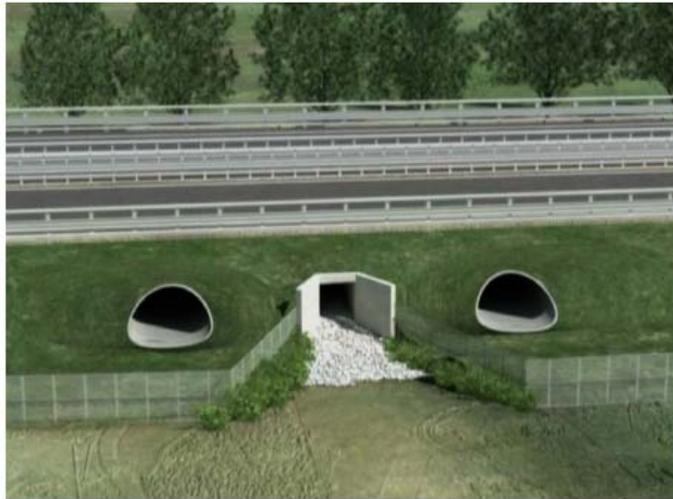
*Fig.3 - Sottopassi ad esclusivo uso faunistico (da [www.arpa.piemonte.it](http://www.arpa.piemonte.it))*
