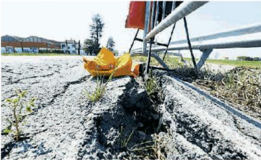
La frana sulla provinciale 24 e il guardrail piegato / FOTORUBIN
