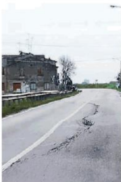
La strada in località Albersano
